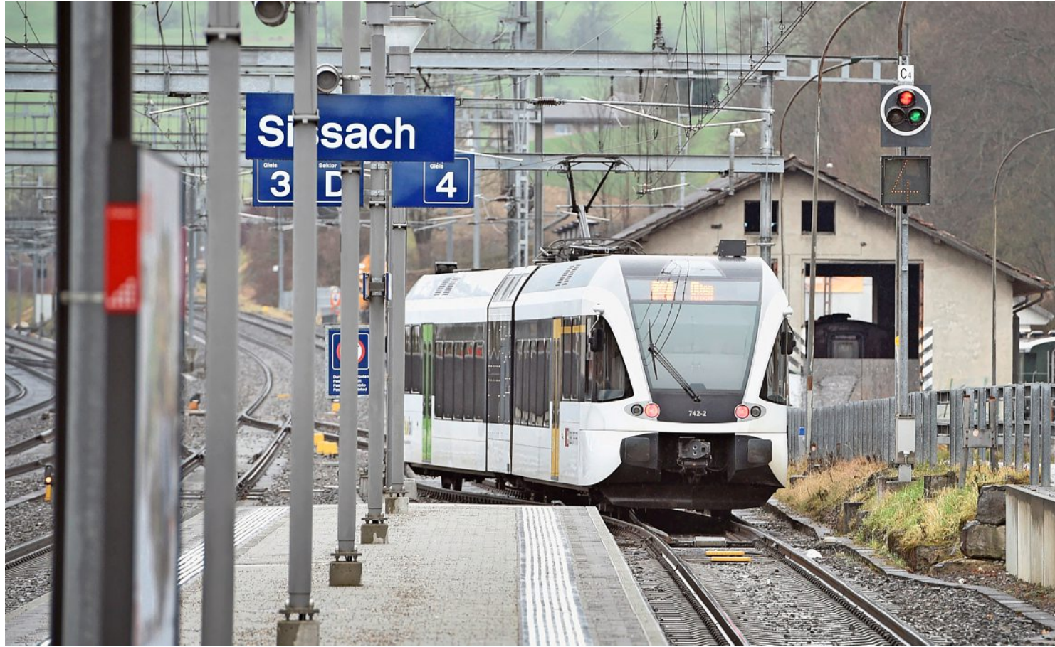
Die Hauenstein-Scheitelstrecke verbindet Sissach mit Olten. Kernstück ist ein knapp 2500 Meter langer Tunnel. Foto: Dominik Plüss
