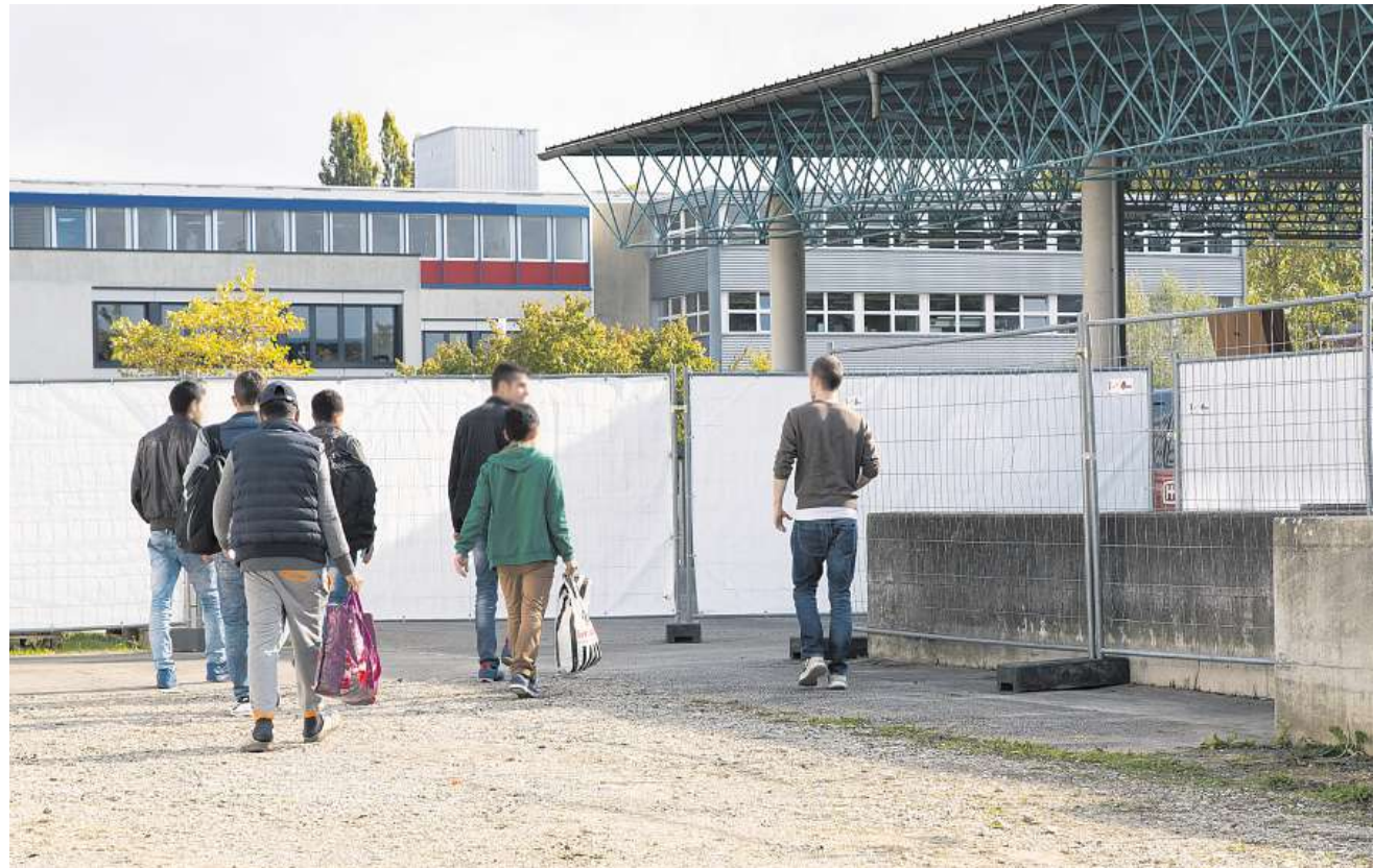
Schnelle Entscheide. In der Allschwiler Zivilschutzanlage Werkhof finden insgesamt 100 Personen Platz.
