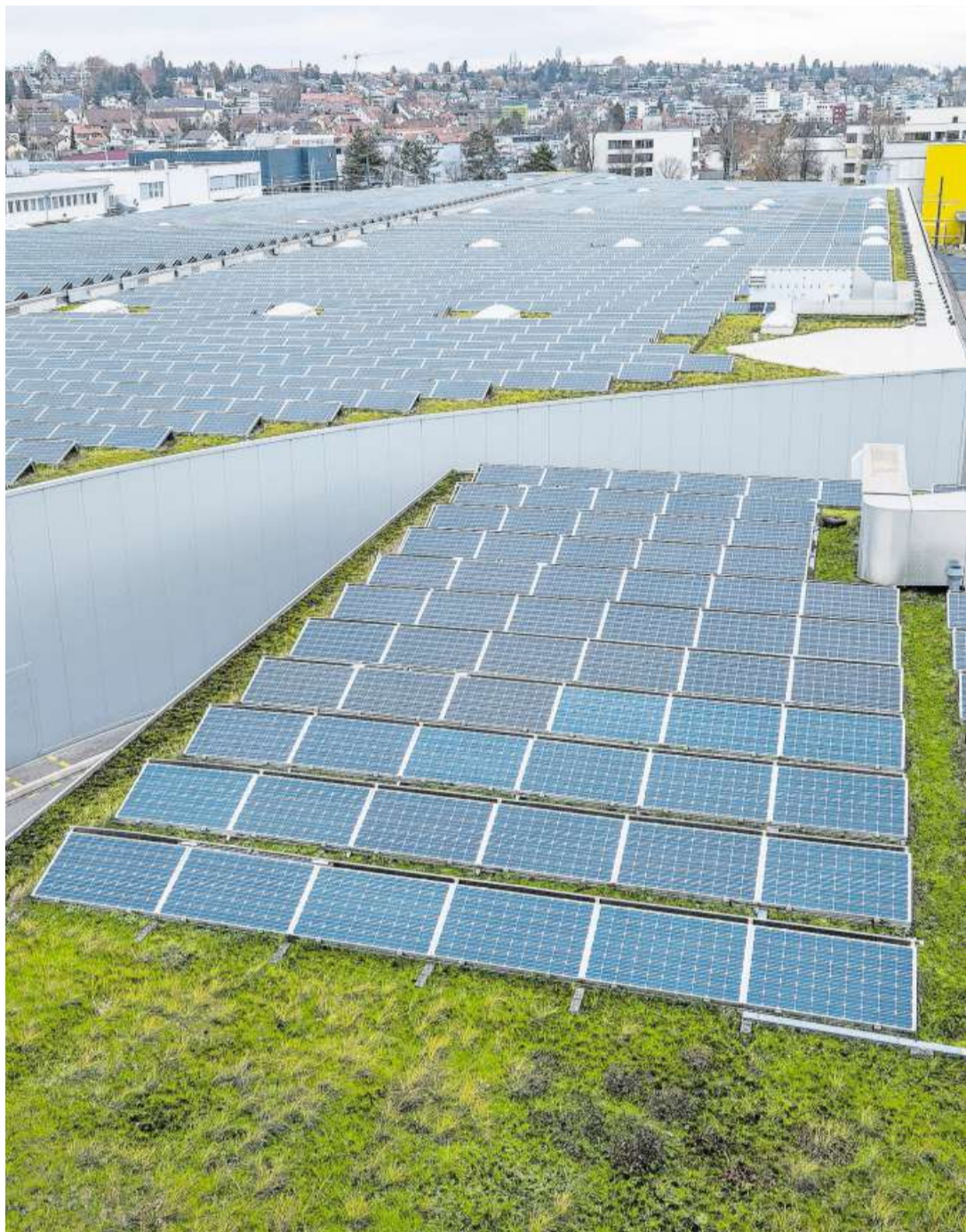
Auf dem Dach des BLT-Depots in Oberwil wird Strom für 270 Haushalte erzeugt.
