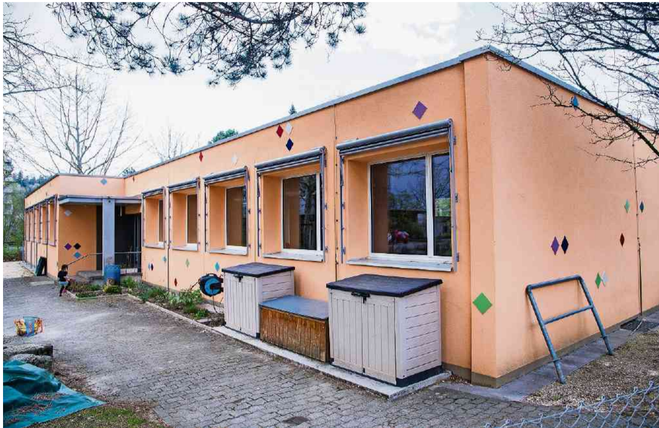
Der Kindergarten Thiersteinerstrasse lässt sich kaum sanieren und wird deshalb aufgegeben.
