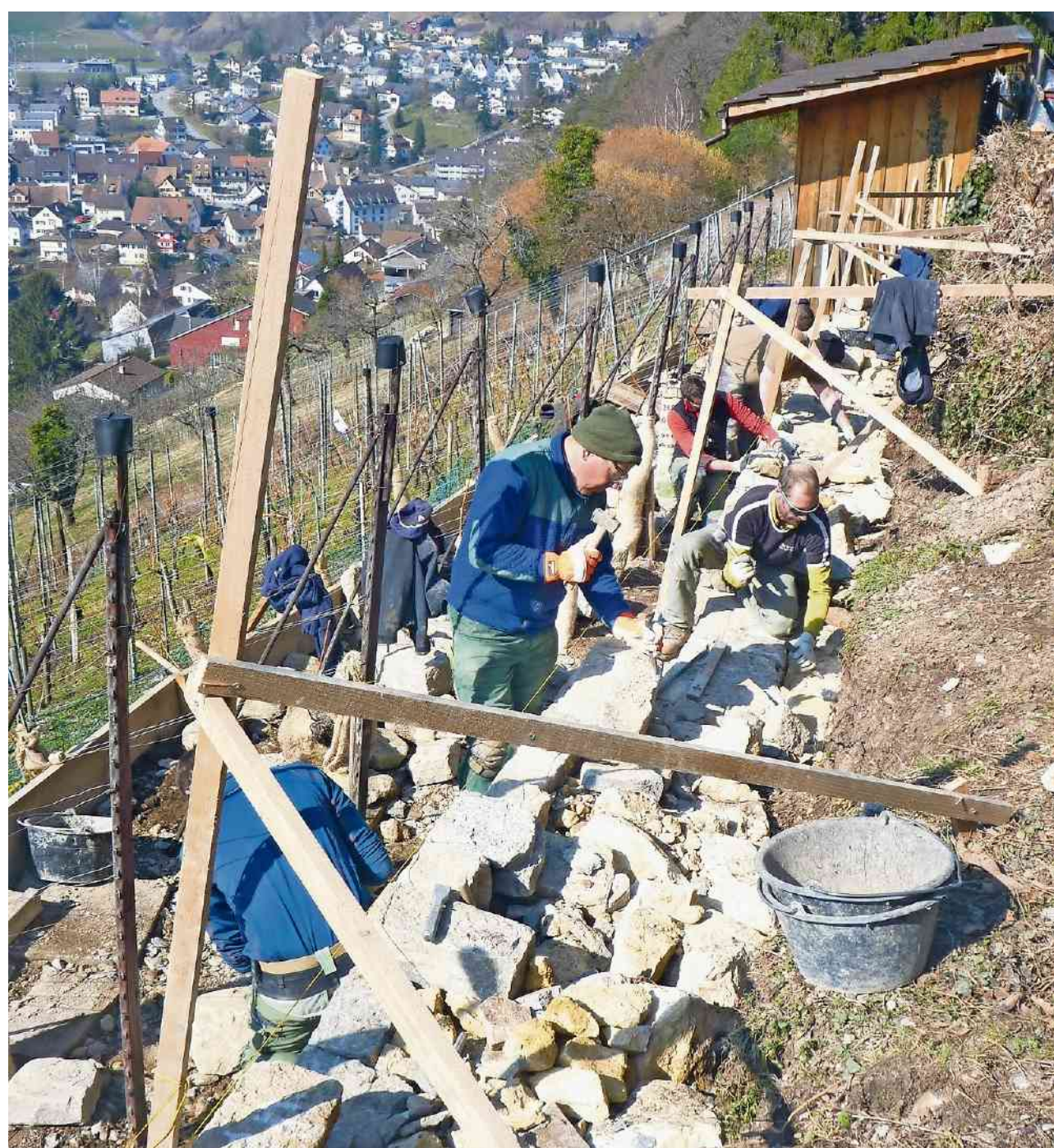
Trockensteinmauern hoch über Oberdorf Derzeit arbeiten sieben Fachleute aus der ganzen Schweiz innerhalb eines Fortgeschrittenen-Kurses an Trockensteinmauern im Rebburg Dielenberg in Oberdorf. Das Fünf-Jahre-Projekt von Pro Natura Baselland und des Weinbauvereins Dielenberg befindet sich im dritten Jahr. Damit soll der Hang auf eine ökologisch sinnvolle Art gesichert werden. (BZ) FOTO: ZVG
