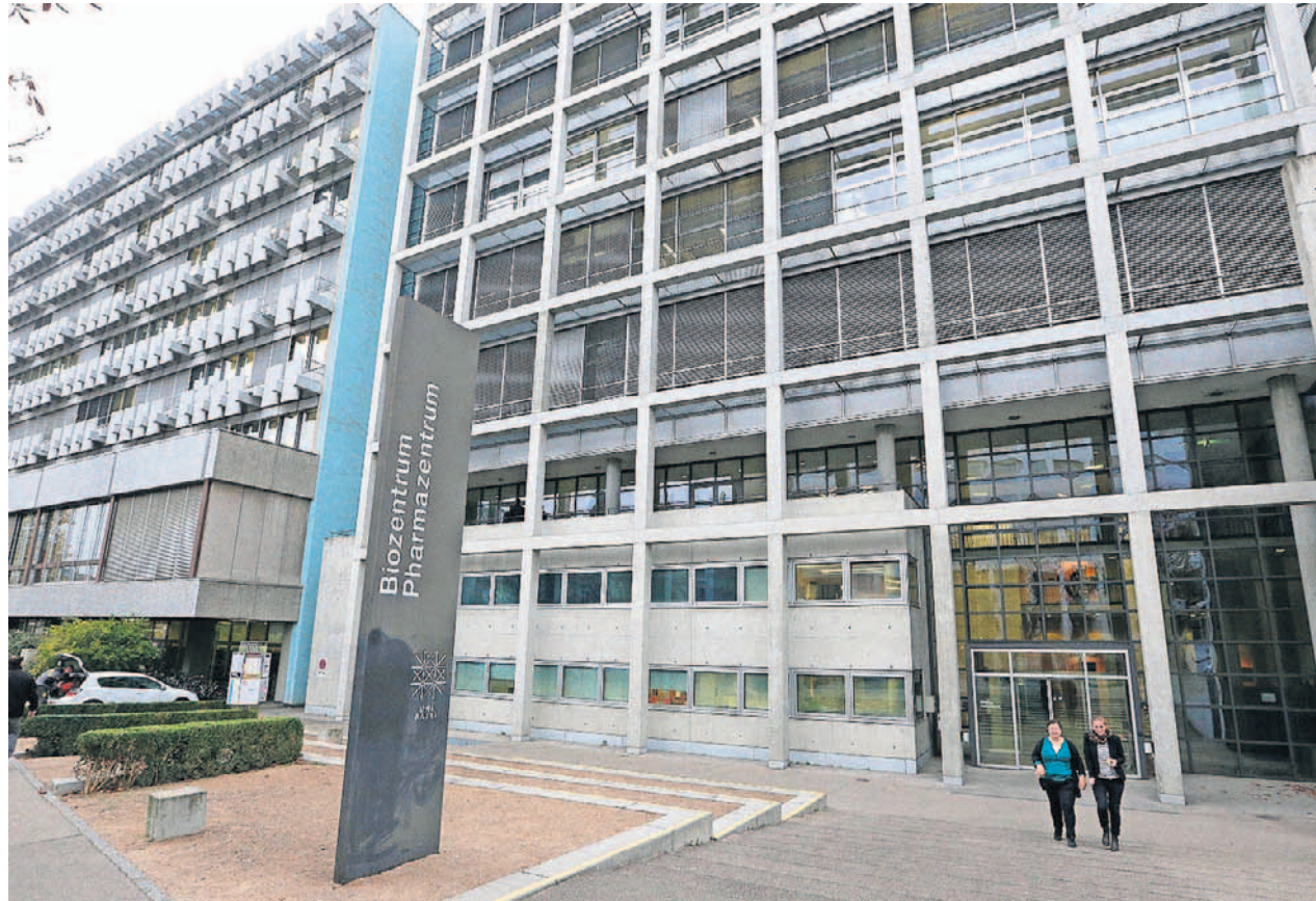
Wird abgerissen: Das 1971 gebaute Biozentrum (linkes Gebäude) an der Basler Klingelbergstrasse.
