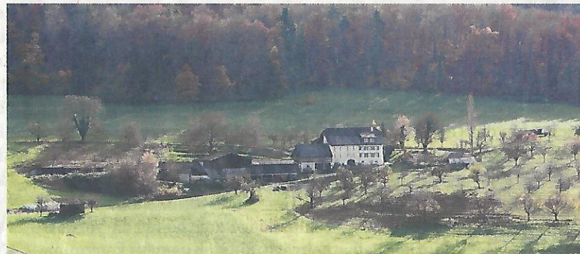
Der rutschende Hang bedroht den Hof von Alfred Suter.
