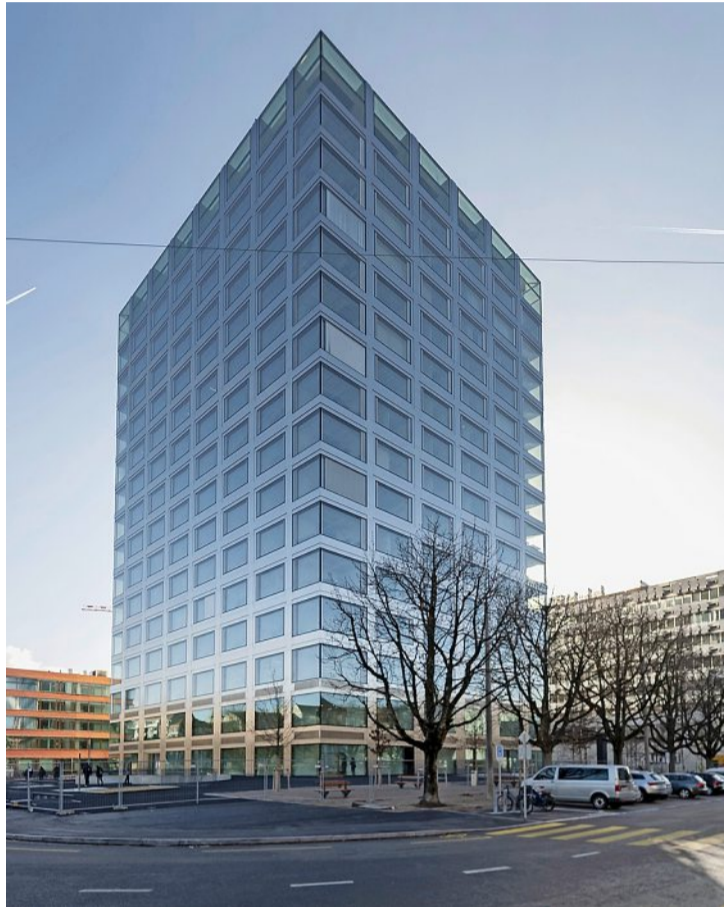
Wegen der Wasserschäden auch «Spülkasten» genannt: der Problembau Biozentrum. Foto: Georgios Kefalas (Keystone)
