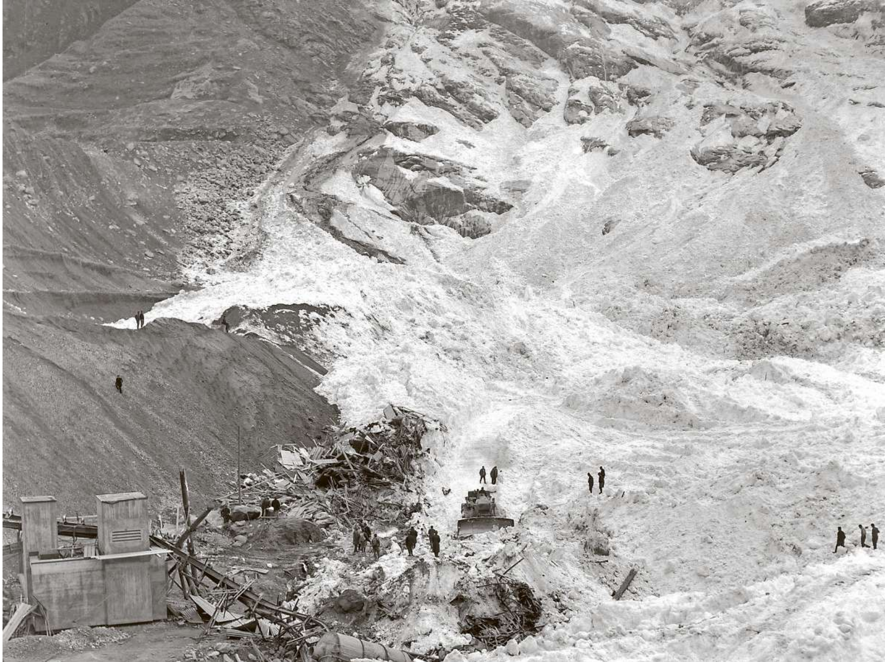
30.8. 1965: Die Katastrophe von Mattmark. Eine Eislawine löste sich vom Allalingsgletscher in der Nähe von Saas Fee und begrub ein Barackenlager beim Mattmark-Stausee. Bis zur Fertigstellung des Staudamms fehlen noch acht Meter in der Höhe. Das Unglück, das 88 Menschenleben forderte, 86 Männer und zwei Frauen, hatte sich angekündigt – immer wieder waren vom Gletscher Eisbrocken abgestürzt. Am 30. August 1965 brach der Gletscher mit gewaltigem Getöse ab, zwei Millionen Kubikmeter Eis begruben das Barackenlager. Dort, wo gerade noch gearbeitet worden war, lag eine rund 50 Meter hohe Eisdecke. Unter den Todesopfern befanden sich 56 Italiener, vier Spanier, zwei Deutsche, zwei Österreicher, ein Staatenloser und 23 Schweizer. Foto Keystone
