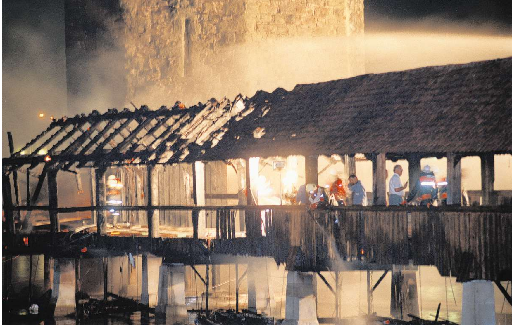
18.8. 1993: In Schutt und Asche. Die Kapellbrücke in Luzern wurde in der Nacht auf den 18. August 1993 ein Raub der Flammen. Die um 1365 gebaute Brücke, die älteste Europas und mit 202,9 Metern zweitlängste nach jener bei Bad Säckingen, wurde vermutlich durch eine weggeworfene Zigarette zerstört. Foto Keystone
