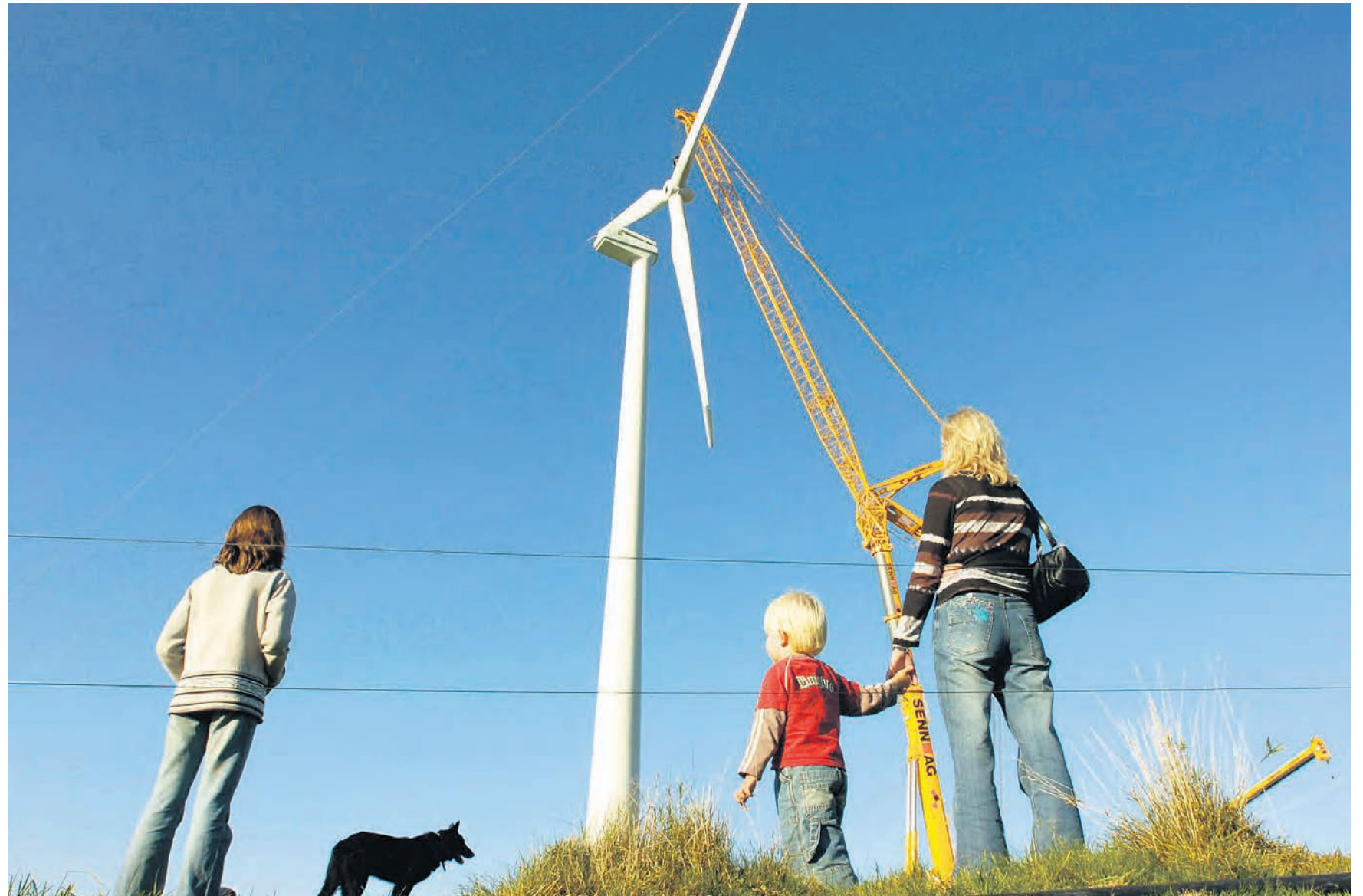
29. 10. 2005: Windkraftwerk bei Entlebuch. Erstmals drehen an diesem Tag die Rotoren des 60 Meter hohen Turms im Wind. Der Bauernhof Feldmoos auf der Rengg (LU) ist der erste in der Schweiz mit einem Windkraftwerk. Diese Anlage konnte nach den damaligen Plänen 300 Haushalte versorgen. Foto Keystone
